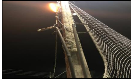
Figura 6 – Improvisações das Fiações elétrica fonte: Próprio autor.
