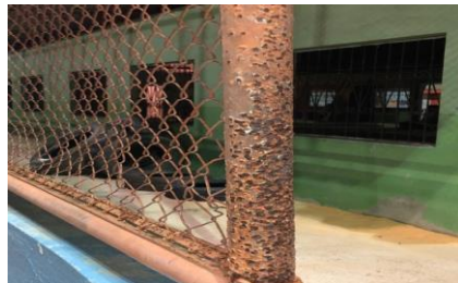
Figura 4 – Gradil de proteção do campo em estado precário devido a falta de manutenção Fonte: Próprio autor
