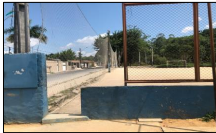
Figura 3 – Foto do Campo existente Fonte: Próprio autor.
