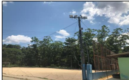
Figura 7 – foto do Campo existente Fonte: Próprio autor.
