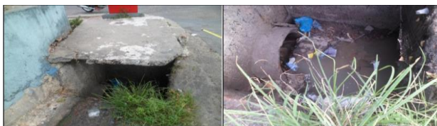
Figura 02 –bocas de lobo do local Fonte: autor (2018)
