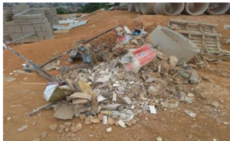
Figure 11 – Resíduos de construção civil depositados em locais inadequados nas obras.- Fonte: Autoria própria, 2018
