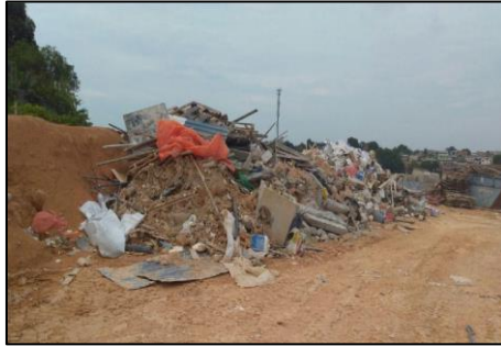
Figure 10 – Resíduos de construção civil depositados em locais inadequados nas obras - Fonte: Autoria própria, 2018.
