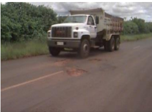
Figura 8: Agravantes da questão: infiltração
