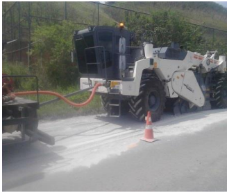
Figura 13: Espalhamento de cimento para início da reciclagem de pavimento asfáltico – RJ-093 em Japeri/RJ
