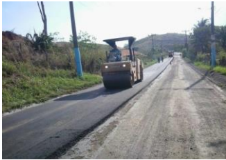
Figura 22: Conclusão dos serviços: Aplicação de CBUQ, RJ-093 em Japeri/RJ
