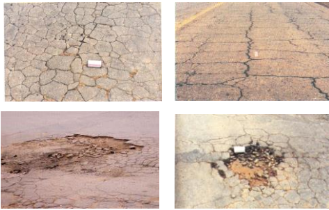
Figura 5: formação de trincas e painéis
