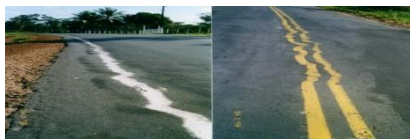
Figura 4: Deformação e sulcos
