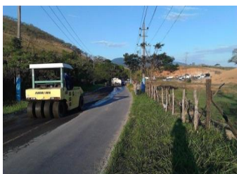
Figura 18: Regularização de base , RJ-093 em Japeri
