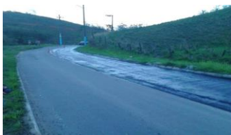
Figura 20: Imprimação de base , RJ-093 em Japeri
