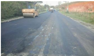
Figura 24: Conclusão dos serviços: Aplicação de CBUQ, RJ-093 em Japeri/RJ
