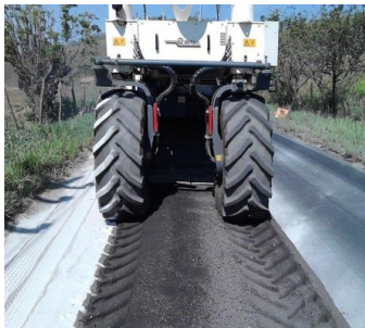
Figura 16: Início do serviço de reciclagem de asfalto com a máquina recicladora, RJ-093 em Japeri
