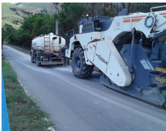
Figura 15: Início do serviço de reciclagem de asfalto com a máquina recicladora, RJ-093 em Japeri
