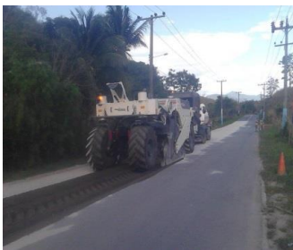
Figura 14: Início do serviço de reciclagem de asfalto com a máquina recicladora, RJ-093 em Japeri
