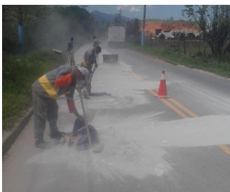
Figura 12: Espalhamento de cimento para início da reciclagem de pavimento asfáltico – RJ-093 em Japeri/RJ
