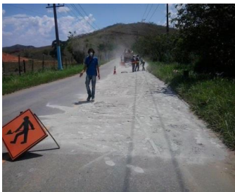
Figura 11: Espalhamento de cimento para início da reciclagem de pavimento asfáltico – RJ-093 em Japeri/RJ
