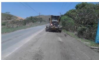
Figura 17: Regularização de base , RJ-093 em Japeri
