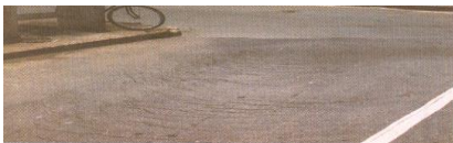
Figura 3: Afundamento decorrido da deformação
