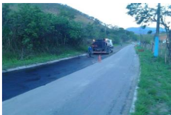
Figura 19: Regularização de base RJ-093 em Japeri
