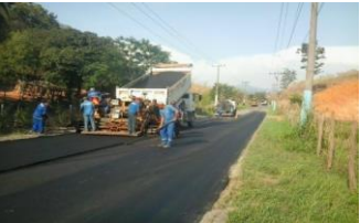
Figura 23: Conclusão dos serviços: Aplicação de CBUQ, RJ-093 em Japeri/RJ
