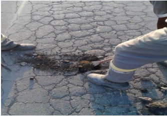
Figura 10: Sondagem onde será feita a reciclagem de asfalto – RJ-093 Japeri
