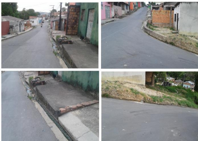
Figura 3. Localização dos aparelhos de drenagens da Rua Alfazema.
