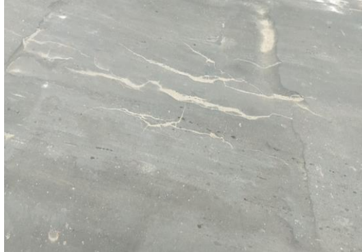
Figura 22. Trincas longitudinais.
