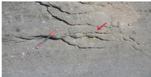
Figura 1. Trinca Transversal com
