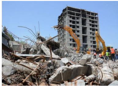
Figura 4 - Resíduos da construção civil. Fonte: RMAI, 2017.
