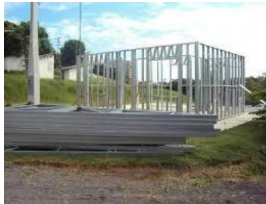
Figura 5 - União dos perfis, processo de construção limpa. Fonte: GOMES; VIVIAN; SICHIERI; PALIARI, 2015.
