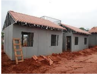
Figura 6 - Fechamento com as placas cimentícias, sem alvenaria, obra limpa. Fonte: GOMES; VIVIAN; SICHIERI; PALIARI, 2015.
