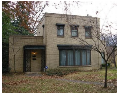
Figura 1 - Casa feita de Steel Frame de 1933, Chicago. Fonte: LSF BLOG, 2017.
