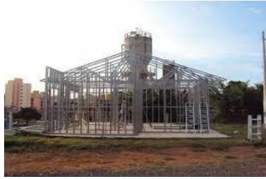
Figura 7 - Sem entulho e sem grandes desperdícios. (IAU/USP São Carlos). Fonte: GOMES; VIVIAN; SICHIERI; PALIARI, 2015.
