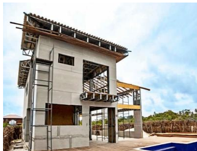
Figura 2 - Casa em steel frame. Fonte: PEREIRA, 2018.
