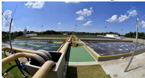
Figura 7: Sistema de tratamento de esgoto de Manaus
