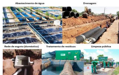
Figura 1: Serviços de saneamento básico.
