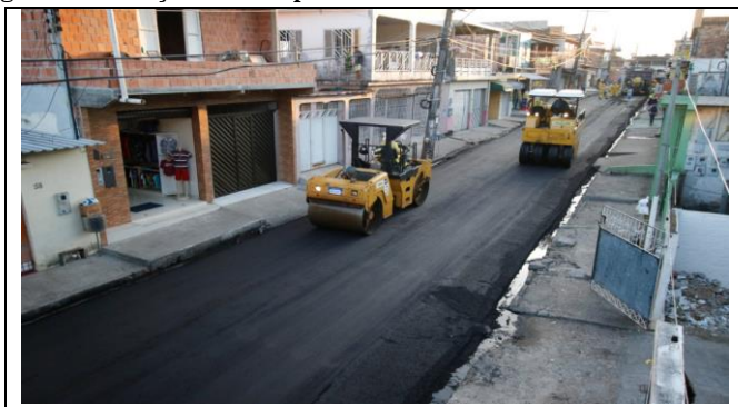
Figura 4: Serviços de recapeamento asfáltico nas ruas de Manaus
