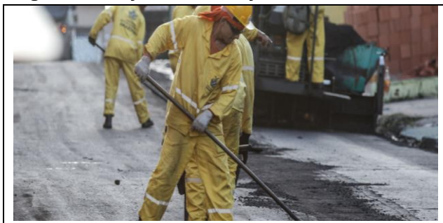
Figura 5: Serviços de restauração asfáltica em Manaus
