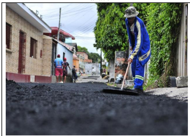
Figura 7: Serviços de pavimentação asfáltica nos bairros periféricos de Manaus
