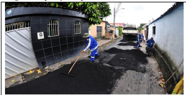
Figura 3: Operação Tapa Buraco nas ruas de Manaus
