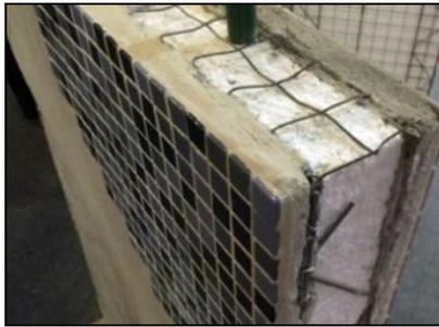
**Figura 3: Isopor entre as duas paredes de argamassa. Fonte: Adaptados pelo autor.**
