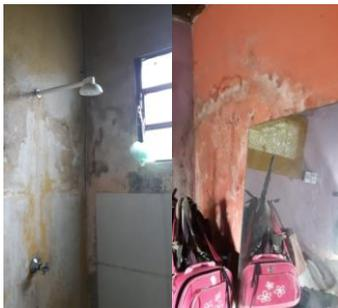
**Figura 2: Infiltração na parede. Fonte: Adaptados pelo autor.**
