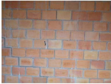
Figura 2: Exemplo eflorescência provocada pela ação da chuva.
