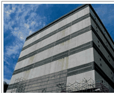
Figura 4: Prédio com manchas de ferrugem na fachada.
