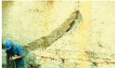
Figura 3: Corrosão da estrutura.
