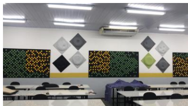
Foto 10: Sala com aplicação de painéis de material acústico na sala 11/E.
