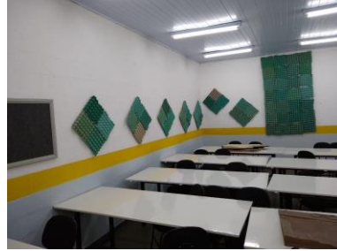
Foto 12: Sala com aplicação de caixas de ovos aplicado na sala 11/E..
