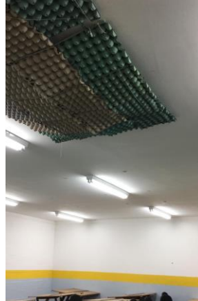
Foto 21: Sala durante a aplicação de painéis de caixas de ovos na sala 07/F.
