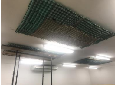
Foto 05: Sala com aplicação de painéis de caixas de ovos na sala 07/F.
