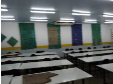
Foto 11: Sala com aplicação de caixas de ovos na sala 11/E.
