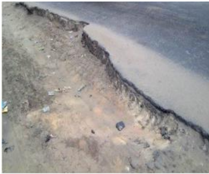
Edge Failure
