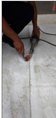
Figura 7: Execução da soldagem a ar quente
