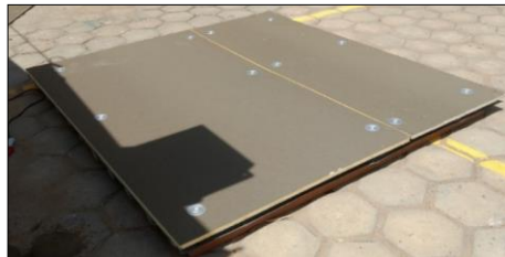
Figura 5: Fixação das placas
