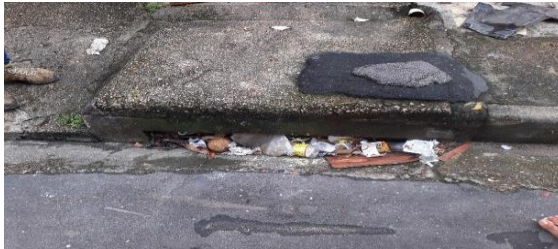
Figura 5 - Boca de lobo com abertura insuficiente e entupimentos
