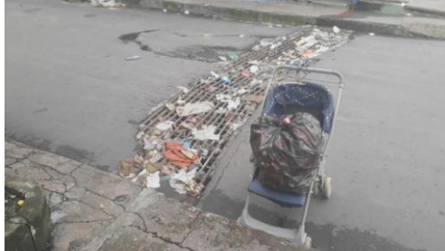
Figura 3 - Despejo irregular de lixos
