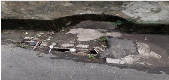
Figura 4 - Boca de lobo com vedação por pavimentação irregular
