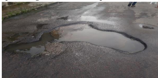
Figura 2 - Tampa de esgoto vedada com pavimento e vazamento
