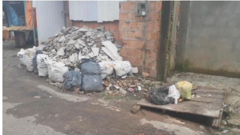
Figura 1 - Lixeira clandestina e boca de lobo com tampa irregular
