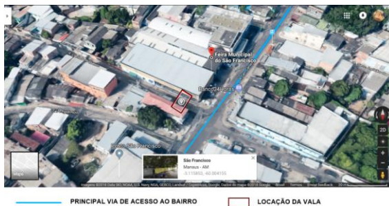
Figura 1 - Vista aérea do terreno da vala coletora
