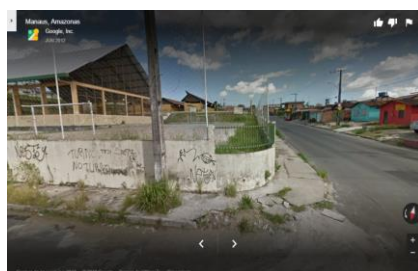
Figura 3 – ausência de rampa de acesso e calçadas totalmente fora do padrão. Fonte: Google Earth.
