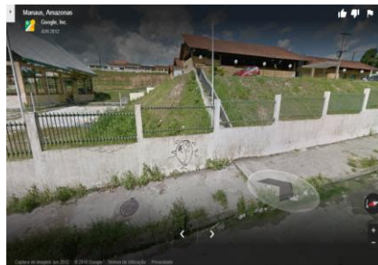
Figura 5 – ausência de rampa de acesso. Fonte: Google Earth.
