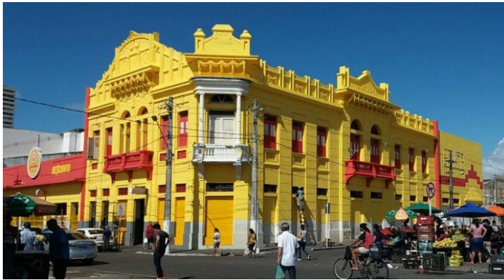
Figura 9 – Exemplo de Retrofit. Loja e Mercado GBarbosa Aracaju – SE Foto: GBarbosa
