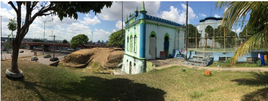
Figura 7 - Reservatório da Castelhana, área externa.
