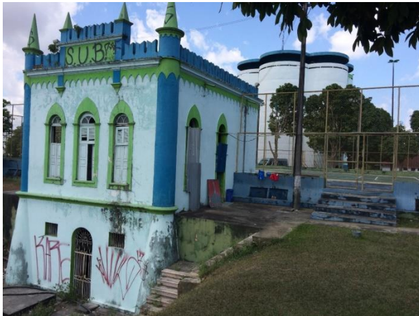
Figura 8 - Reservatório da Castelhana, área externa. Fonte: próprio autor.
