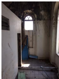
Figura 6 - Reservatório da Castelhana, área interna
