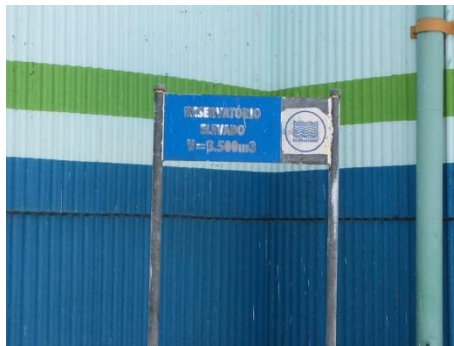
Figura 8 - Reservatório da Castelhana, reservatório elevado. Fonte: próprio autor.
