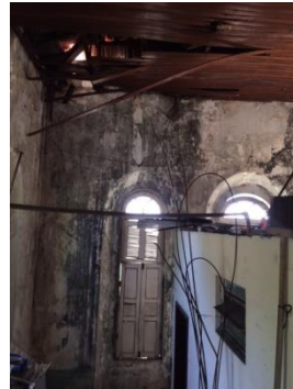
Figura 5 - Reservatório da Castelhana, área interna
