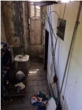
Figura 4 - Reservatório da Castelhana, área interna
