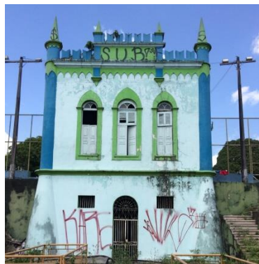
Figura 3 - Reservatório da Castelhana, área externa. Fonte: próprio autor.
