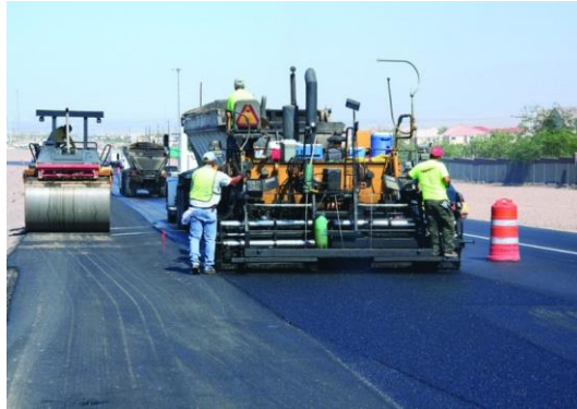
Figura 5: Pavimentação com pneus inservíveis
