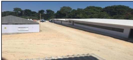
Figura 15: canteiro de obra Residencial Cidadão Manauara. Fonte Próprio autor
