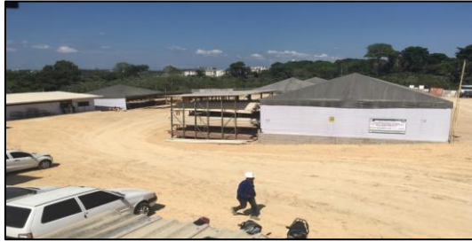
Figura 14: canteiro de obra Residencial Cidadão Manauara. Fonte Próprio autor
