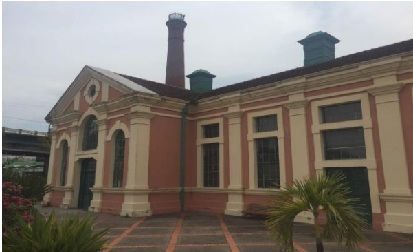
Figura 4 – Usina Chaminé. Fonte: próprio autor.
