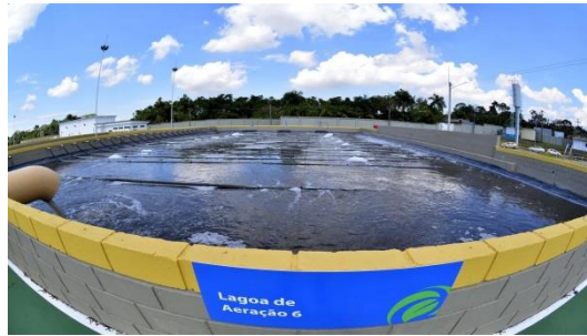
Figura 2 – Estação de Tratamento de Esgoto (ETE) Timbiras. Fonte: Mácio James/ Semcom.
