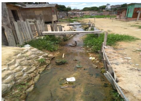
Figure 6 – Antes de ter Saneamento Básico Comunidade Canaã - Fonte: Autoria Própria, 2018.
