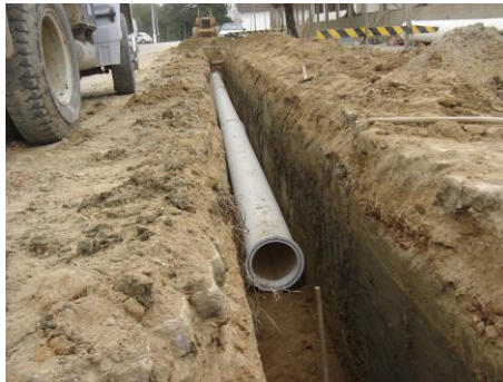
Figure 7 – Alocação dos Tubos (PA1 ao PA4), de 60 a 200 cm na Comunidade Canaã- Fonte: Autoria Própria, 2018.
