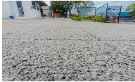
Figura 2 Pavimento em Concreto Permeável Fonte: Projeto batente.
