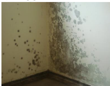
Figura 05: Bolor devido à umidade. [15]
