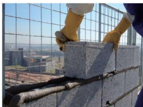
Figura 02: Detalhe dos Componentes da Alvenaria Estrutural. [4]
