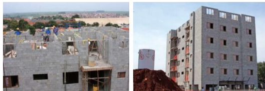
Figura 01: Alvenaria Estrutural de Blocos de Concreto. [4]
