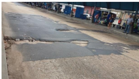
Figura 8: Placas do trecho B com reparos irregulares. Fonte: Autores, 2018.
