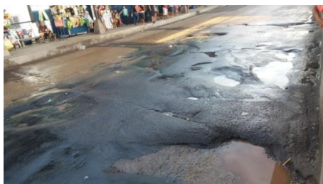
Figura 9: Placas do trecho B com reparos irregulares. Fonte: Autores, 2018.
