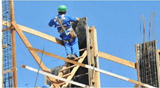
Figura 4. Montagem das formas dos pilares
