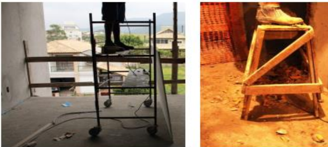
Figura 5. Falha na proteção coletiva
