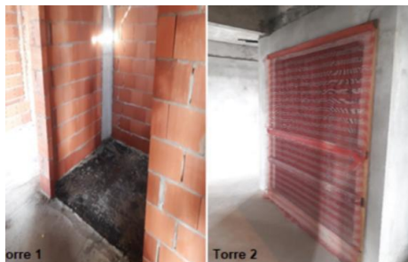
Figura 7. Abertura em Vão de Piso (Poço do Elevador)
