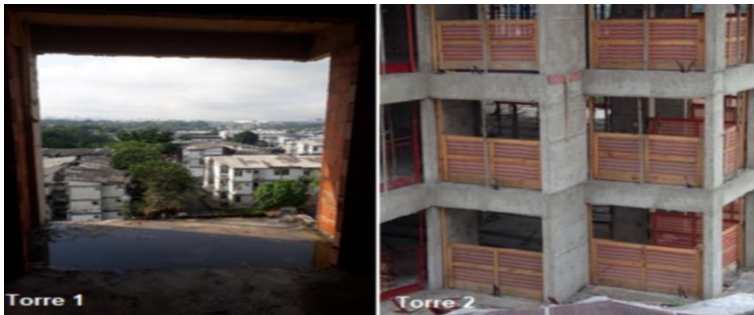
Figura 6. Proteção de Periferia (Guarda-corpo)
