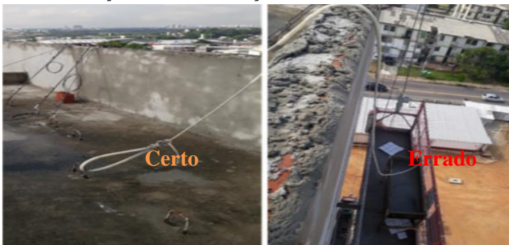
Figura 8. Amarração do cabo na alça metálica
