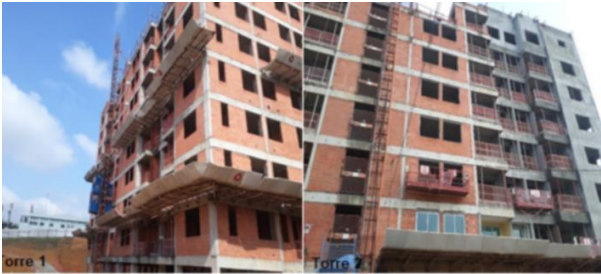
Figura 3. Edificação em processo construtivo
