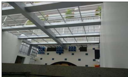
Figura 15: Área interna do hospital
