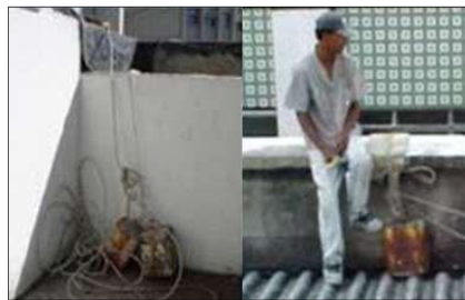
Figura 6: Sustentação dos andaimes de modo incorreto
