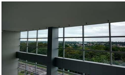
Figura 16: Pontos de ancoragem área interna
