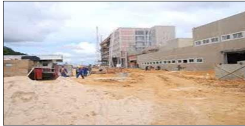
Figura 13: Construção do Hospital Delphina Rinaldi Abdel Aziz
