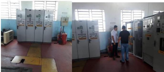
**Figura 5** - Alimentadores e Sistema de Proteção da Subestação.
