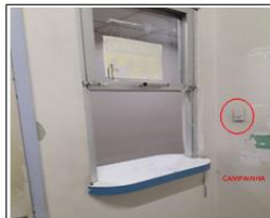
CABINE DE RECEBIMENTO E DISPENSAÇÃO
