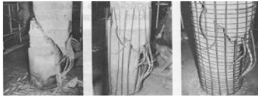
Figura 4 – Sequência de fotos de construção de pilar – Incêndio Edifício Grande Avenida, São Paulo, 1981. Fonte: http://zonadmerico.blogspot.com.br/2014/04/tembranca-incendio-do-edificio-grande-avenida.html . Acesso em 25/11/2015.
