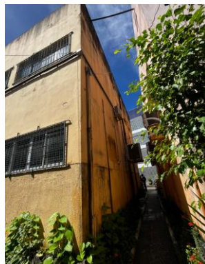
Figura 9 – Fachada lateral direita do bloco H
