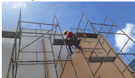
Figura 17 – Pintura do bloco H
