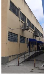
Figura 01 – Fachada frontal do bloco H
