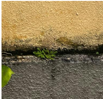
Figura 25 –Vegetação na fachada posterior do bloco H
